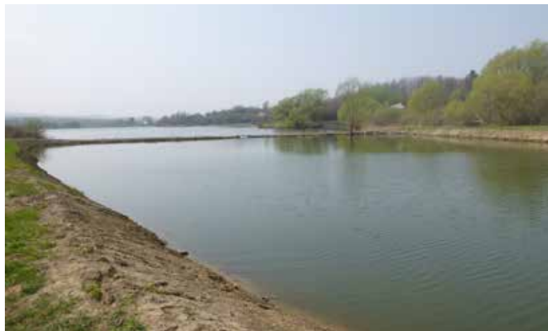
↓ Usazovací nádrž Ordějov po vytěžení sedimentů ↑
