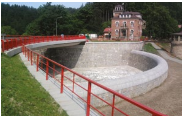
↑ II. etapa: VD Bystřička – rekonstrukce přelivu – bezpečnostní přeliv a mostní objekt po rekonstrukci
