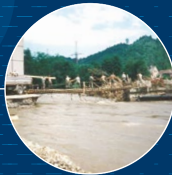
Řeka Morava, Hanušovice, odstraňování zříceného silničního mostu v sídlišti (vojsko)
