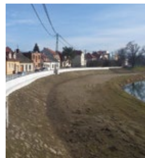
↑ II. etapa: Morava, Uherské Hradiště, Staré Město – zvýšení kapacity koryta II. etapa – nábrežní PB zeď v Rybárnách
