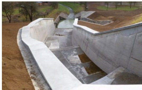
↑ II. etapa: VD Fryšták – zkapacitnění skluzu – pohled na skluz z koruny hráze
