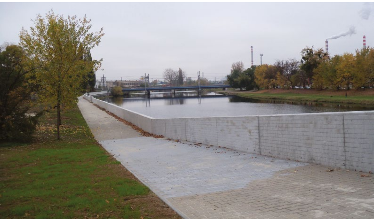
↓ III. etapa: Bečva, Přerov – protipovodňová ochrana nad jezem – 1L/08 – nábřežní betonová zídka
