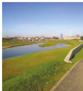
↑ II. etapa: Morava, Olomouc – zvýšení kapacity koryta II. etapa A – zkapacitnění koryta mezi mosty U dětského domova a ul. Velkomoravská
