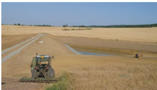
↓ II. etapa: SN Černá – byla vybudována suchá nádrž o objemu 40 tis. m 3 .
