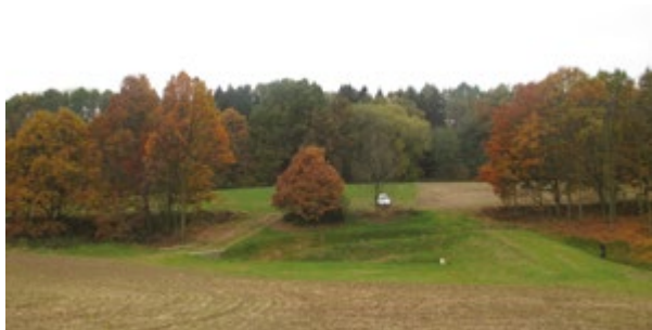
↑ II. etapa: Suché nádrže a zasakovací svodné průlehy Zábřeh–Ráječek – byly vybudovány 2 suché nádrže o celkovém objemu 2,6 tis. m 3 a svodné průlehy o celkové délce 375 m.
