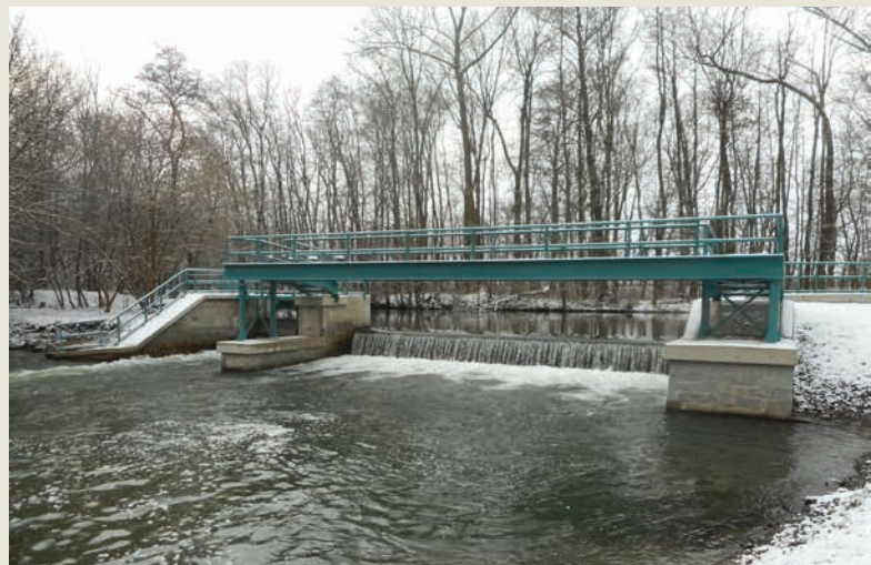
↑ Nová lávka přes Střední Moravu na jezu Tři Mosty
