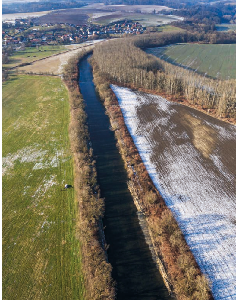
Napřímená řeka Bečva nad obcí Ústí. ↑ Právě této obci by zahájená revitalizace měla za povodní nejlépe odlehčit.
