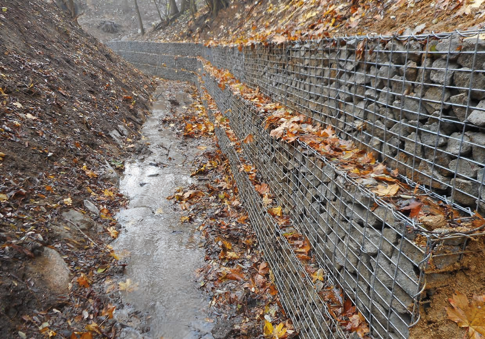
Gabionové opěrné zdivo Našiměřického potoka sahá místy až do výšky 2 m ↑
