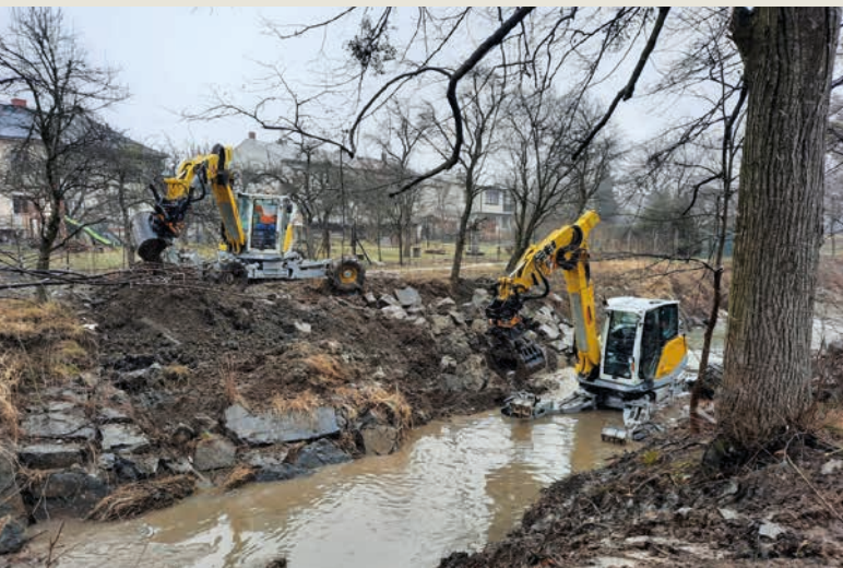
↑ Oprava výtrže v Bystřici pod Hostýnem
