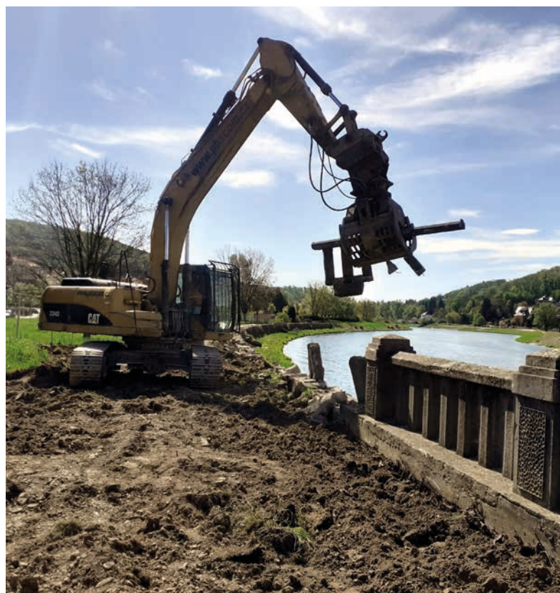
Začátkem května začaly stroje rozebírat nevyhovující zídky v Hranicích ↑
