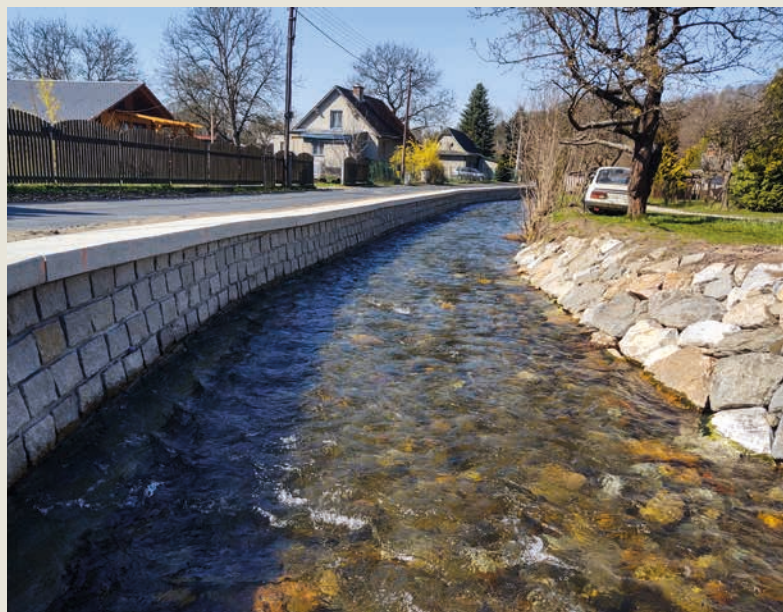
Založení opěrné zdi bylo komplikované díky blízké komunikaci ↓
