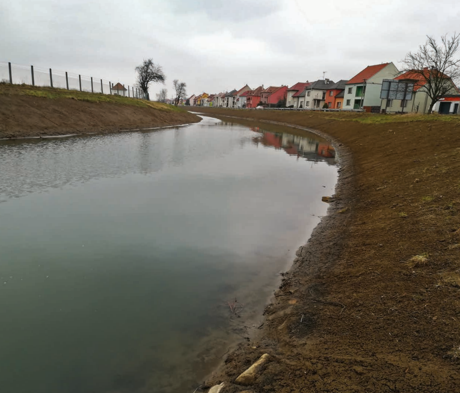
Řeka Olšava v Těšově po opravě nátrží způsobených ledy ↑
