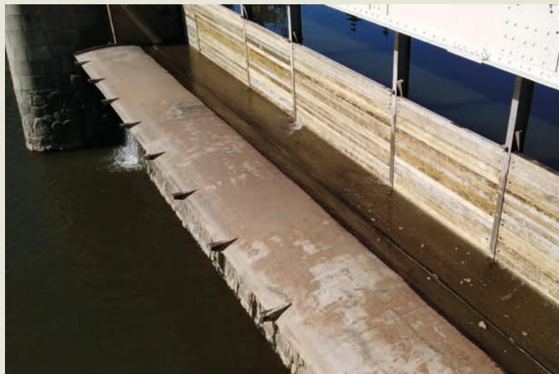
Zahrazení jezového pole ↑
