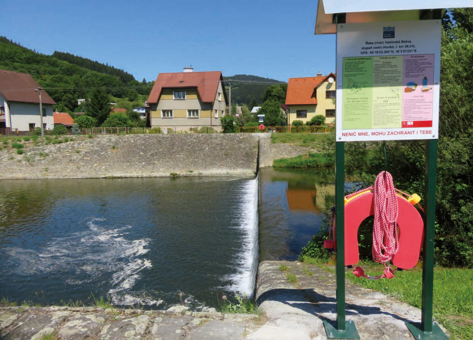
Stupeň v Hovězí s osazenými záchrannými prvky ↑
