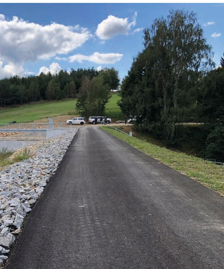
VN Martinice po rekonstrukci ↓
