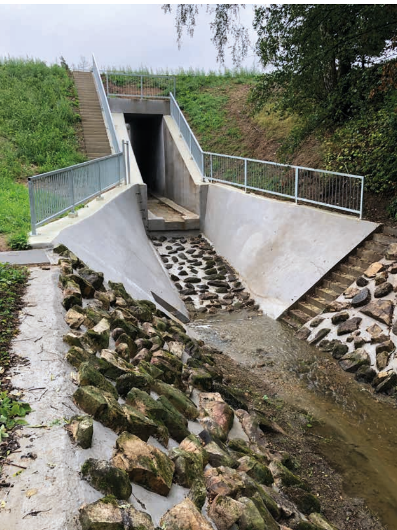
Funkční objekt VN Martinice po rekonstrukci ↑
