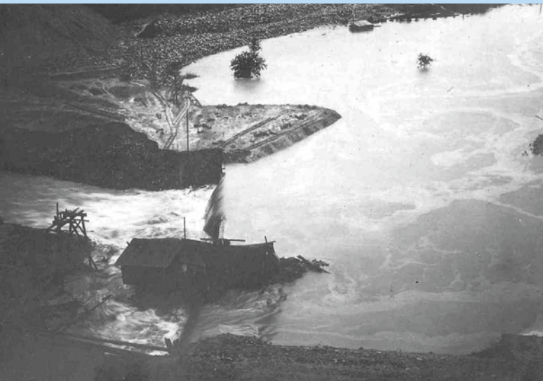
↑ Povodeň se nevyhnula ani stavbě – povodeň při výstavbě v roce 1911
