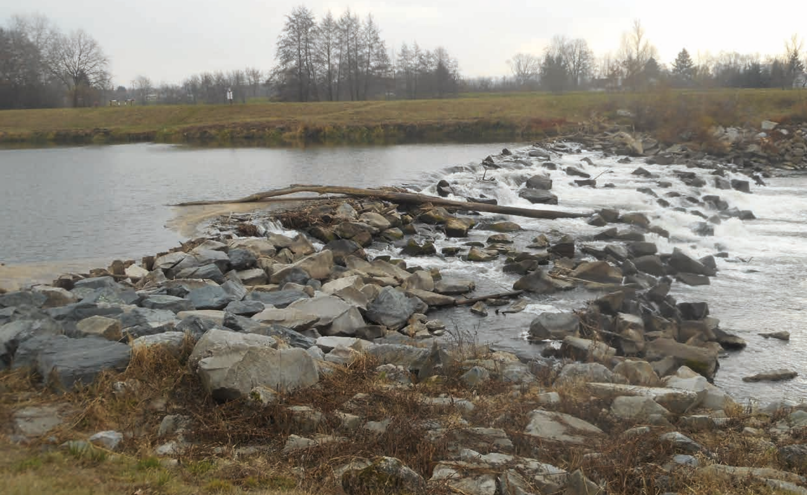
Balvanitý skluz před a po opravě ↑↓
