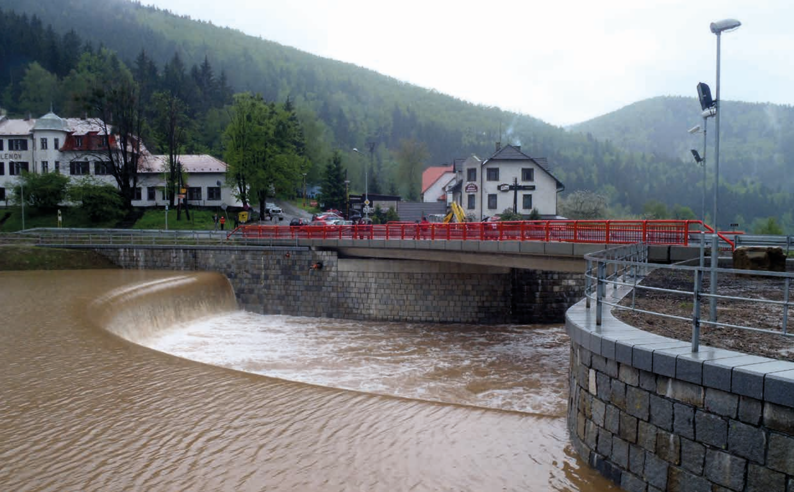
Bezpečnostní přeliv při průchodu povodně v květnu 2010 ↑
