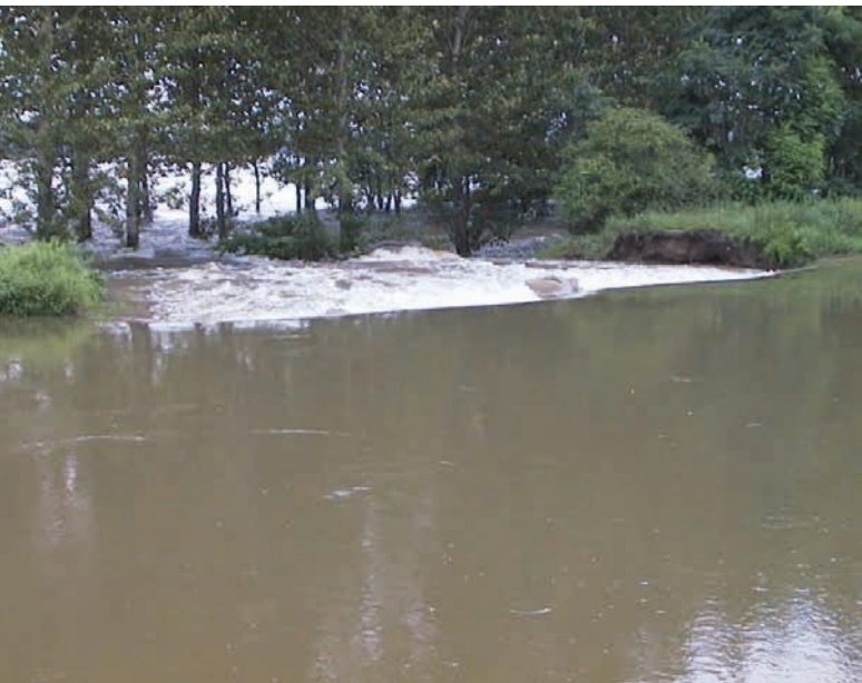
↑ Protřzená hráz – Dyjskomlýnský náhon, 15.00 hod., 14. 8. 2002
