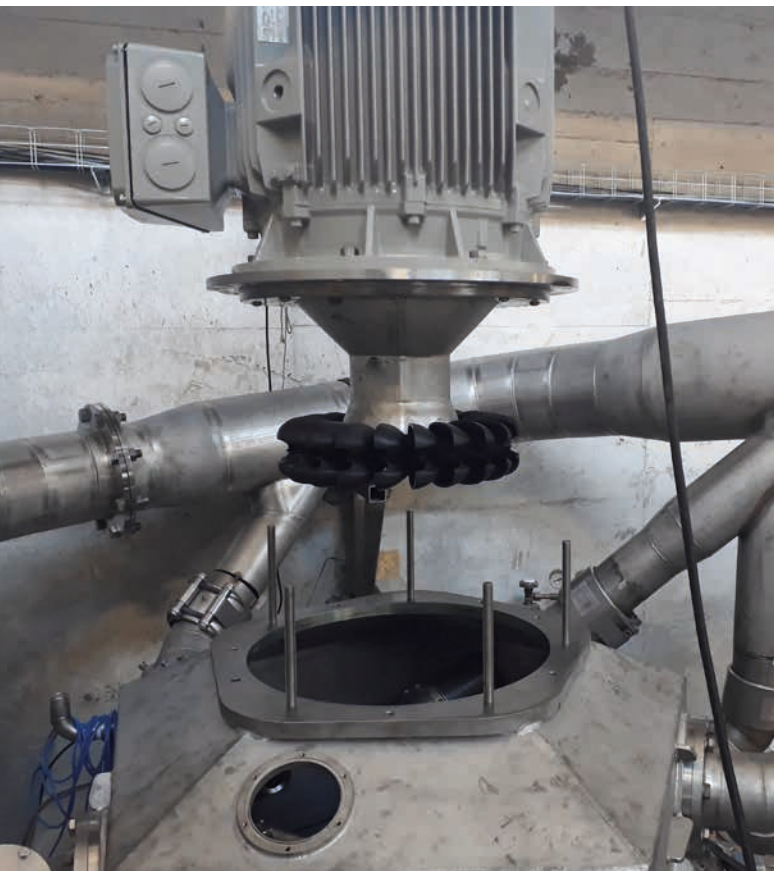
↑ Montáž generátoru s oběžným kolem ↓ Detail oběžného kola Peltonovy turbíny s lopatkami
