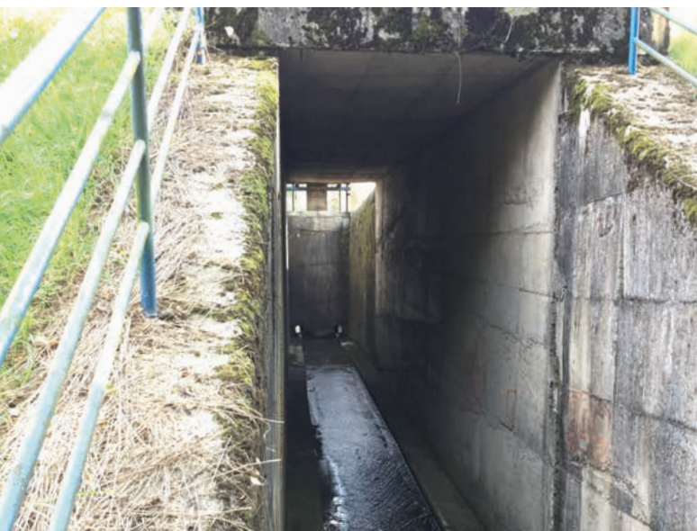
↑ Funkční objekt VN Martinice před rekonstrukcí
