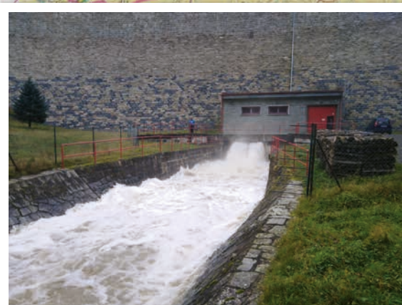
PM od 13 hod dne 20. 9. 2020 navýšil odtok Spodní výpusti VD Bystřicka k naředění koncentrace kyanidů na patnáctinásobek
