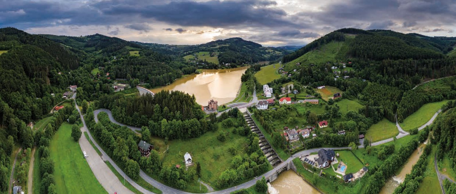
VD Bystřička 1 – významné vodní dílo pro transformaci povodní a nadlepšování průtoku v korytech VT ↑
