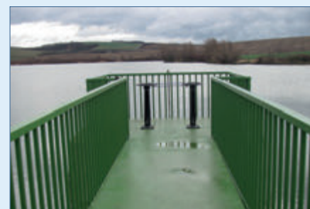
VD Těšany, ovládání spodních výpustí
