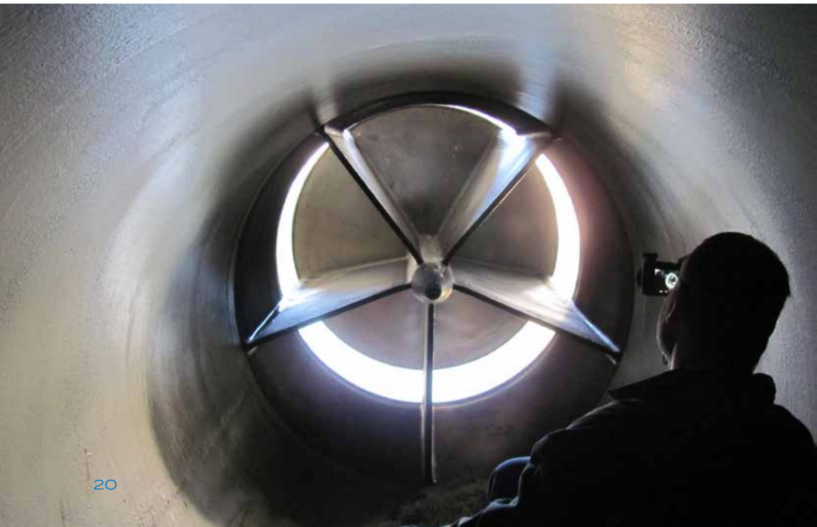
↓ Pohled z vnitřku potrubí na rozstřikovací uzávěr
