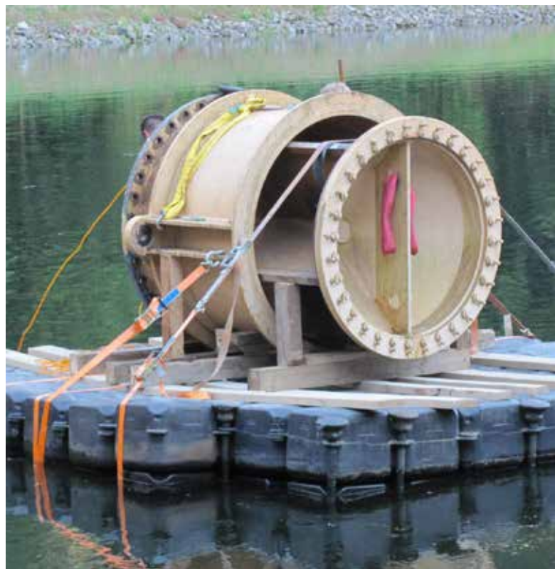
Odvoz rozstřikovacího uzávěru na pontonu ↑
