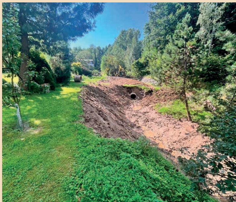
... a po zabezpečení ↓
