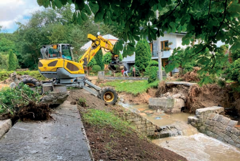
↑ Oprava břehů v obci Šišma
