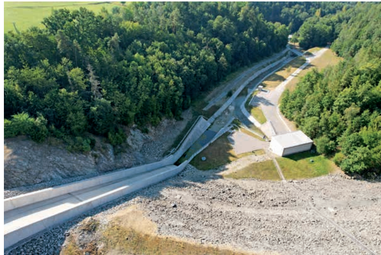
Opravené koryto pod vodní nádrží Boskovice ↑
