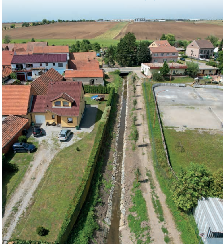
... a po opravě ↓
