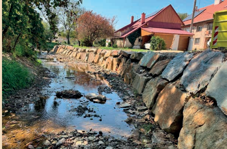
Zabezpečení koryta v Šišmě ↑
