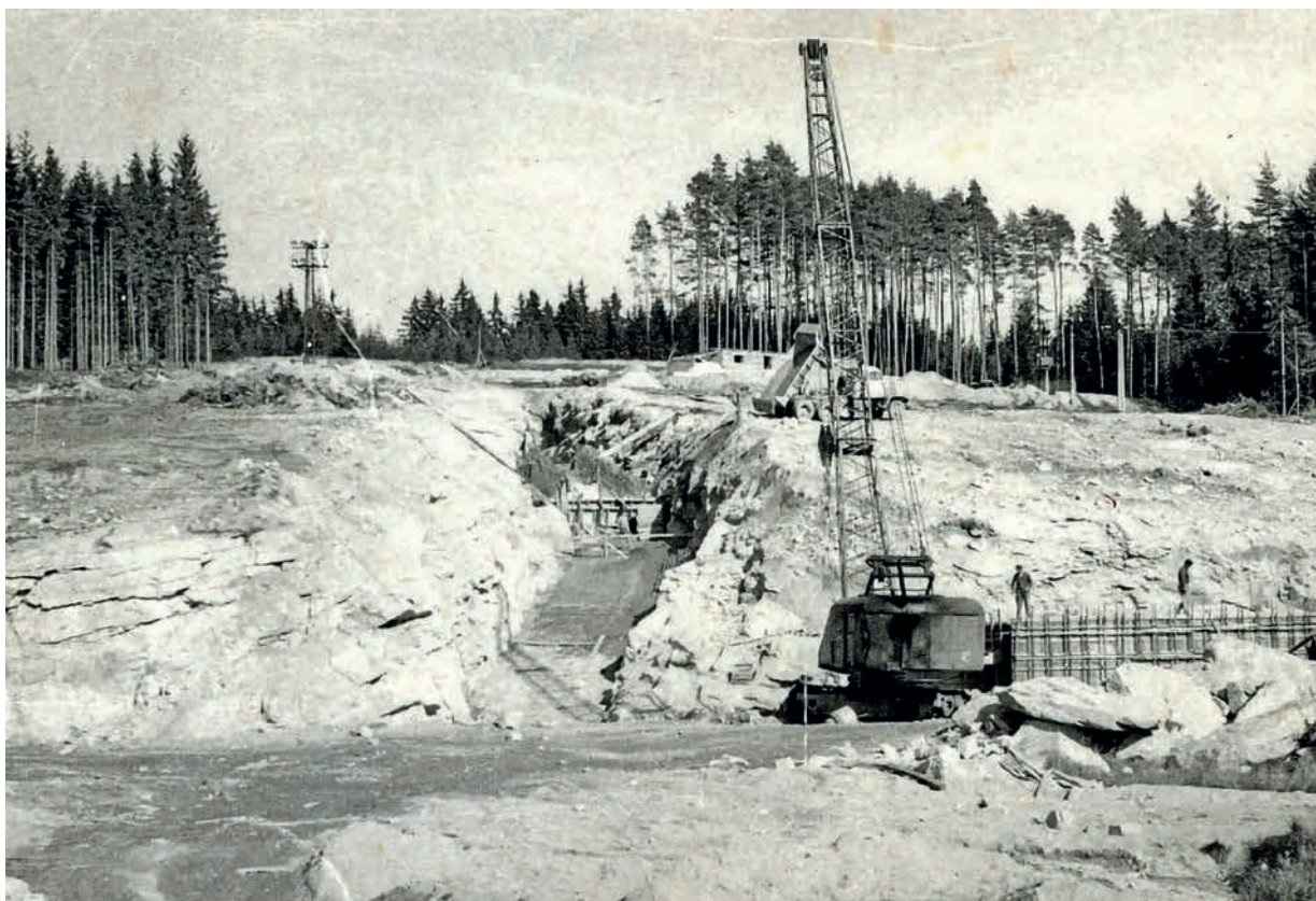
Pohled z pravého břehu na zakládání hráze VD Landštejn ↑
