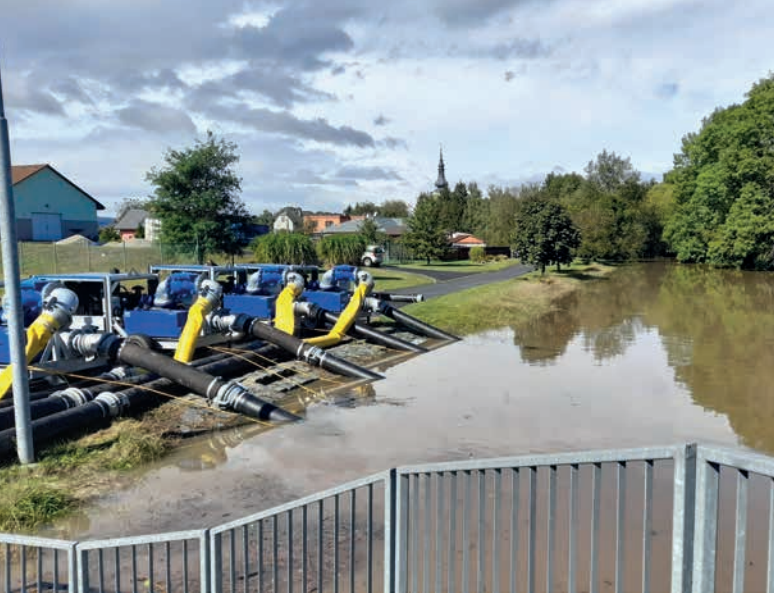
↑ Čerpání vody pomocí velkoobjemových čerpadel, které jsou součástí PPO Moravičany-Třebůvka ↓ Ochranné zídky dokončené v roce 2023 ochránily obec Herálec na řece Svatce
