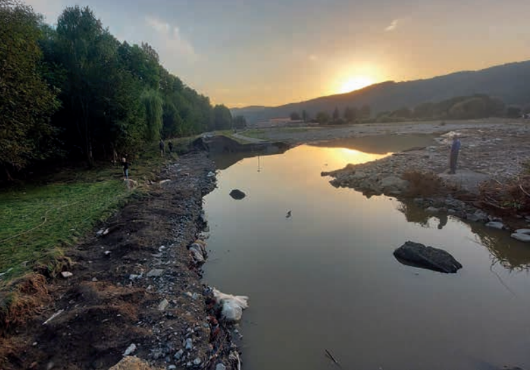
↑ Práce na stavbě prozatímní ochranné hráze v Rudě nad Moravou, která byla v důsledku překročení kapacity ( Q_{100} ) rozplavena – foto dne 17. 9. 2024 a 31. 10. 2024
