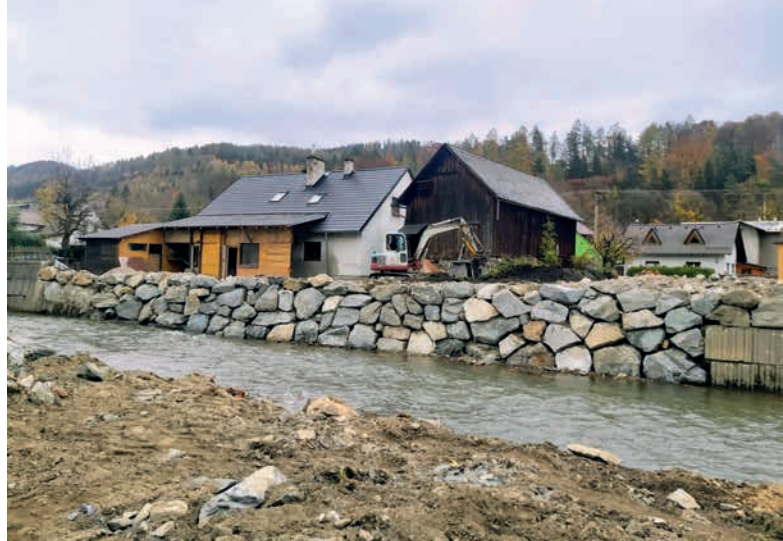
↑ Zabezpečovací práce nemovitostí nad rozplavenou protipovodňovou zdí v Bohdíkově (26. 9. 2024) a po provedení zabezpečení (31. 10. 2024)
