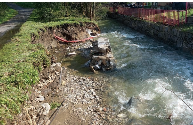
↑ Rozplavená opěrná zeď řeky Branné v Ostružné a práce na jejím zajištění (září 2024) ↓ Zabezpečení rozsáhlé břehové nátrže řeky Desné u Rapotína
