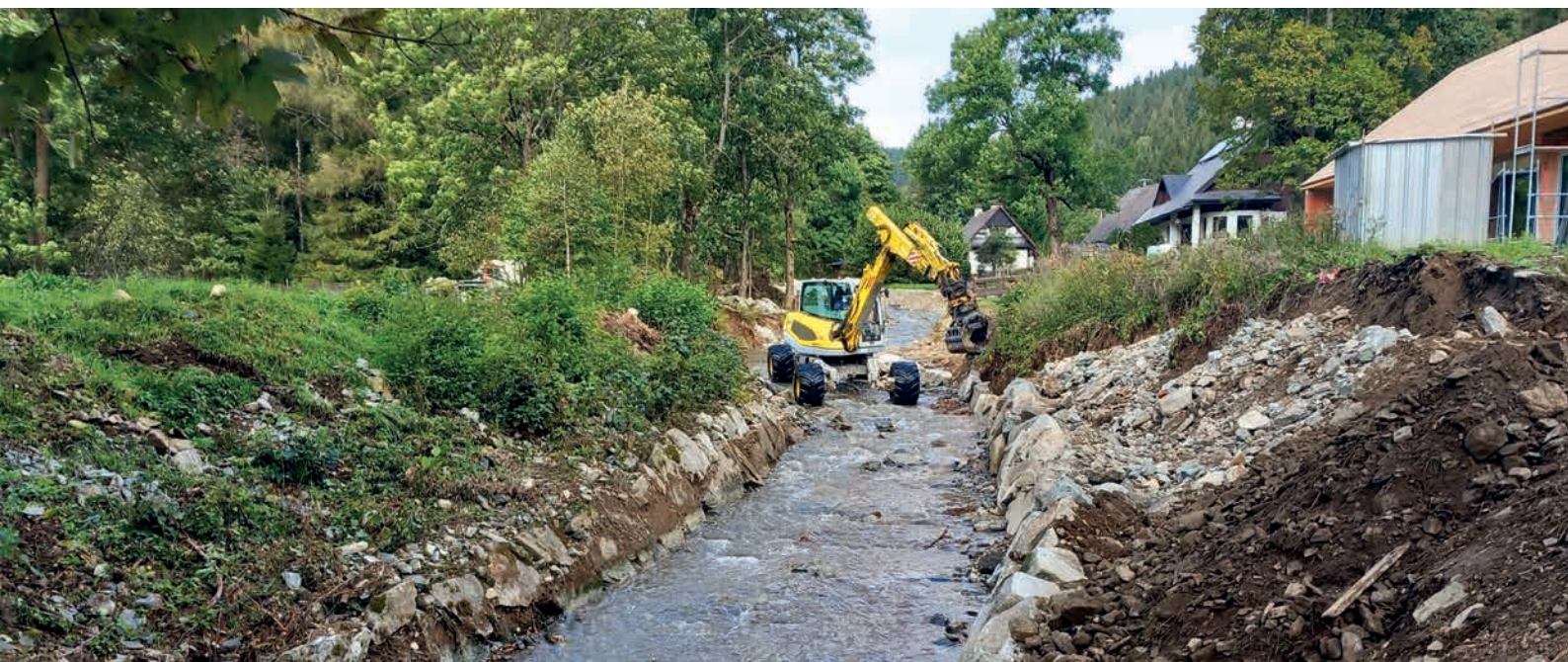
↑ Sanace břehové nátrže a její stabilizace pomocí kamenného záhozu – řeka Branná ↓ Práce na zajištění panelového domu na sídlišti v Hanušovicích, který řeka Morava podemlela ve stejném místě jako v roce 1997
