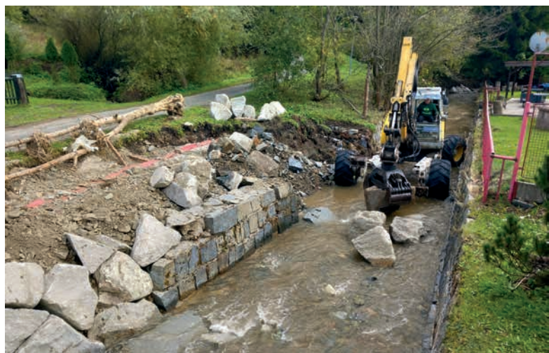
↑ Zabezpečovací práce nemovitostí nad rozplavenou protipovodňovou zdí v Bohdíkově (26. 9. 2024) a po provedení zabezpečení (31. 10. 2024)
