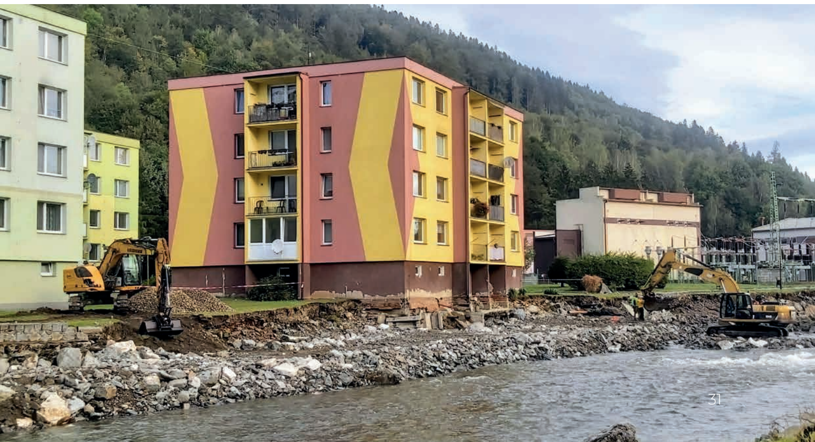
↑ Sanace břehové nátrže a její stabilizace pomocí kamenného záhozu – řeka Branná ↓ Práce na zajištění panelového domu na sídlišti v Hanušovicích, který řeka Morava podemlela ve stejném místě jako v roce 1997
