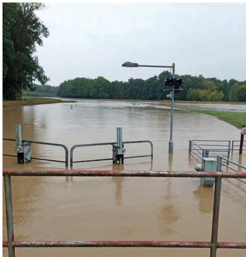
Zaplavená dolní rejda plavební komory Nedakonice ↑
