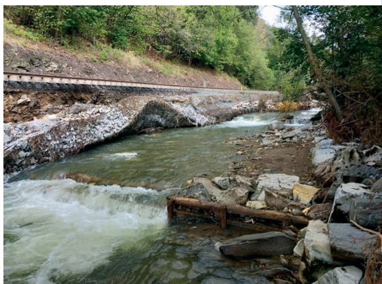
Poškozená konstrukce pevného jezu na řece Branná v Jindřichově Řeka Branná, Hanušovice – Jindřichov ↓
