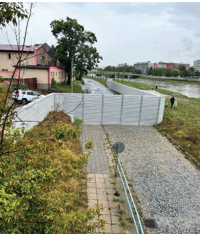
↓ Osazené mobilní hrazení v protipovodňové ochraně města Přerov 14. 9. 2024
