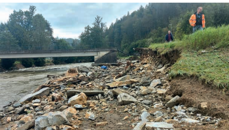
↑ Povodňová škoda na levobřežním břehovém opevnění řeky Moravy v Hanušovicích ↓ Řeka Branná v Ostružné
