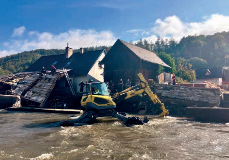
↑ Zabezpečovací práce nemovitostí nad rozplavenou protipovodňovou zdí v Bohdíkově (26. 9. 2024) a po provedení zabezpečení (31. 10. 2024)
