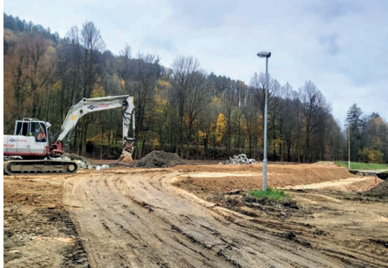
↑ Práce na stavbě prozatímní ochranné hráze v Rudě nad Moravou, která byla v důsledku překročení kapacity ( Q_{100} ) rozplavena – foto dne 17. 9. 2024 a 31. 10. 2024
