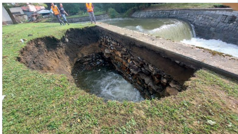
Poškozená konstrukce pevného jezu na řece Branná v Jindřichově Řeka Branná, Hanušovice – Jindřichov ↓
