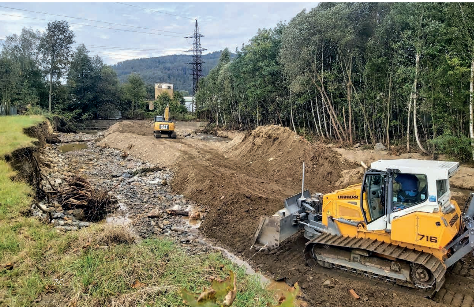
↑ Rozplavená opěrná zeď řeky Branné v Ostružné a práce na jejím zajištění (září 2024) ↓ Zabezpečení rozsáhlé břehové nátrže řeky Desné u Rapotína
